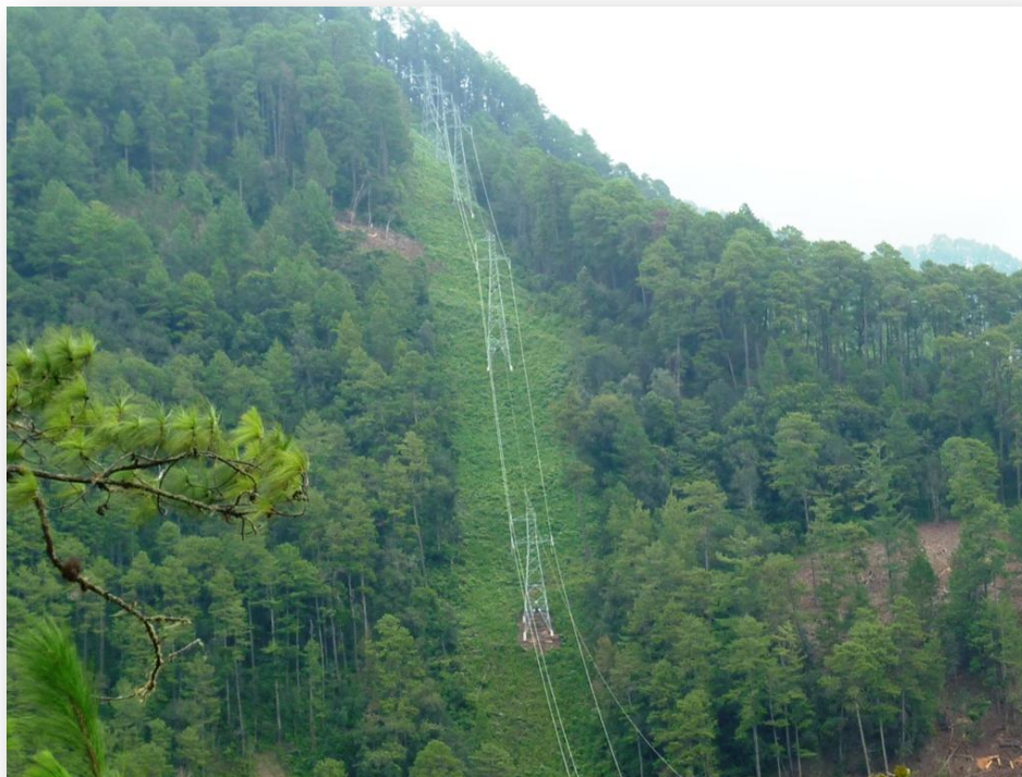
Figura 12. Torres, tendido eléctrico y deforestación, Nebaj.
